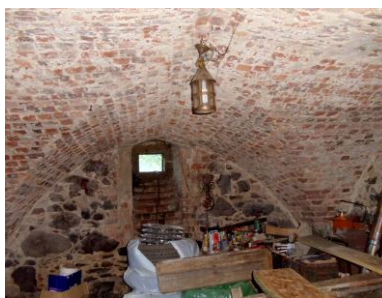
Kellerraum mit Gewölbe
