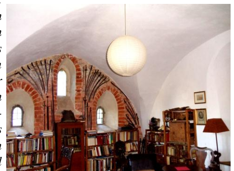
Erdgeschoss heute als Bibliothek und Arbeitsraum genutzt
