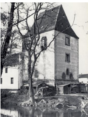
Südstseite vor 1945 mit verputzter Fassade, Wassergraben und Aborterker dieses Raumes hinweisen sollte Im 3. Obergeschoss ist auf der Südseite ein Aborterker zu sehen, während unten der noch vorhandene Wassergraben zu sehen ist. Bis auf die verputzte Fassade hat sich nach
