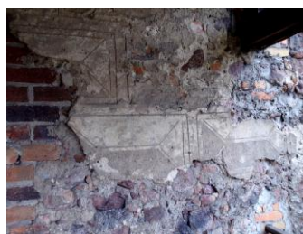
Reste der Sgraffito-Fassade
