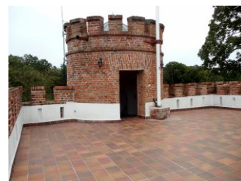
Dachaufsicht mit Eingang zur Treppe
