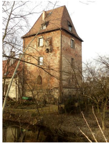
Südstseite heute, unverputzt mit Wassergraben u. Aborterker
