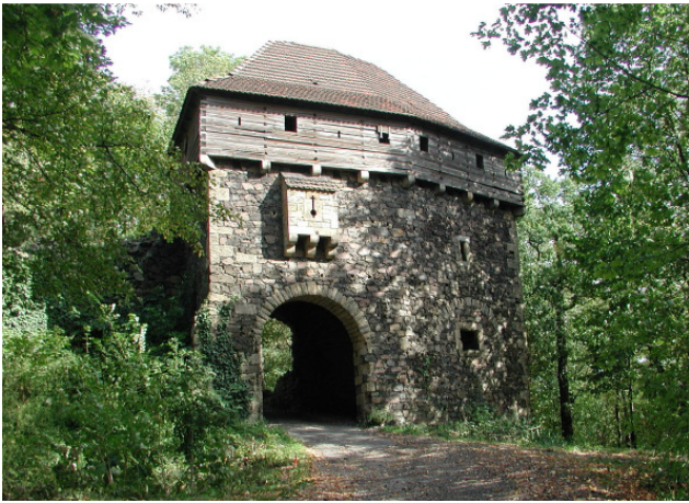
Torhaus der Vorburg
